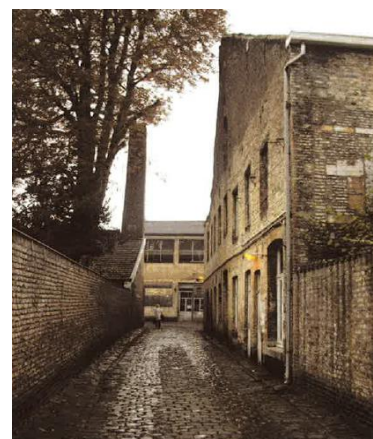
De fabrieksschoorsteen uit 1857
