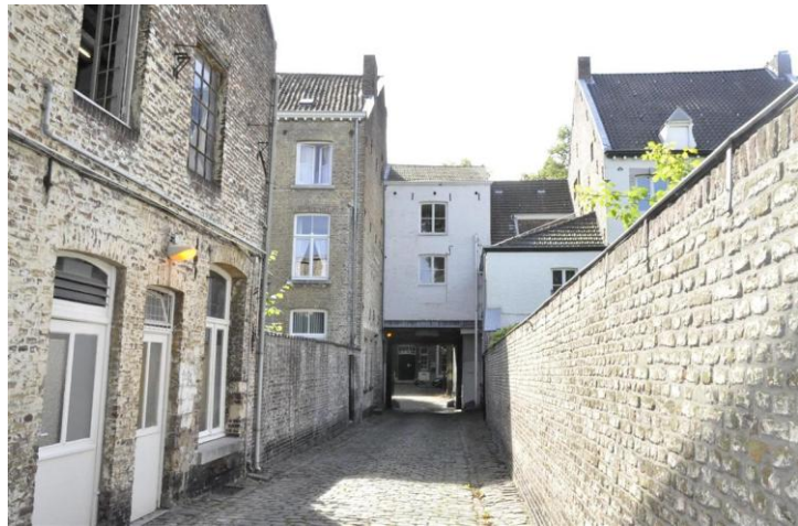
Toegangsweg (zicht richting Grote Looiersstraat) met links het vml. magazijn
