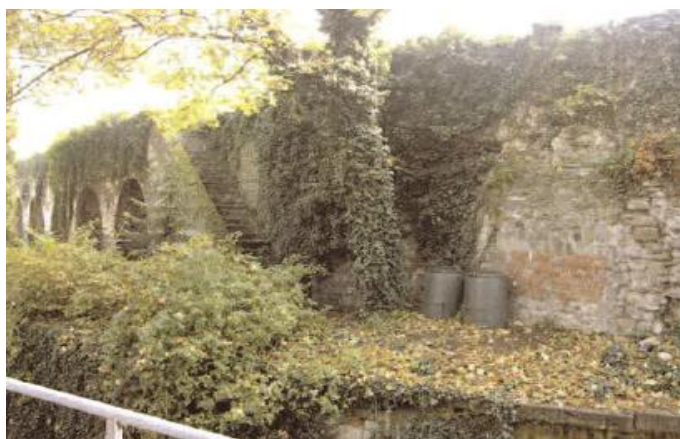
Binnenzijde stadsomwalling gezien vanuit fabrieksterrein
